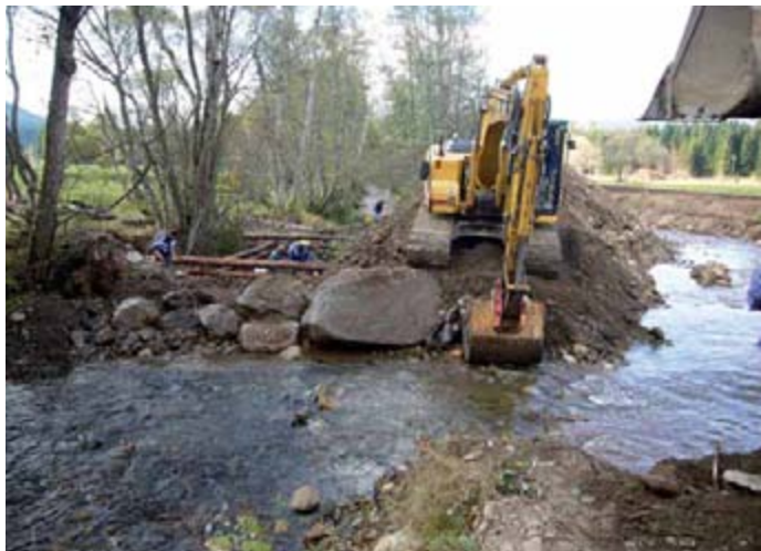
Wiederherstellung früherer Mäanderschleifen am zur Trift begrabigten Kolbersbach - mit dem Bagger in wenigen Stunden erledigt (Foto: Ingo Brauer)
