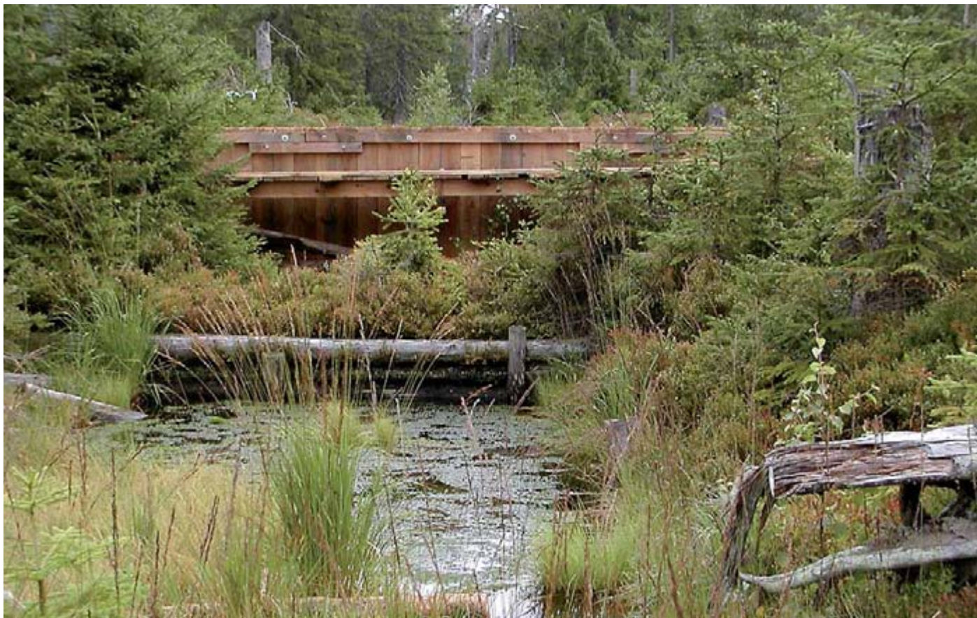
Durch Spundwände, die bis an die Hochmooroberfläche reichen, werden die früher mit schlecht abdichtenden Methoden verbauten Entwässerungsgräben effektiver angestaut (Foto: Karl-Heinz Englmaier)
